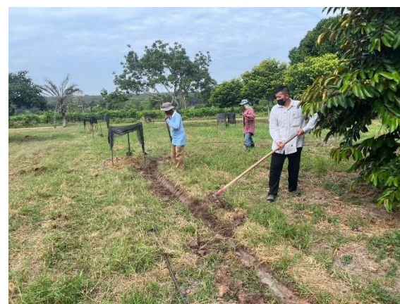
ติดตั้งระบบน้ำ
