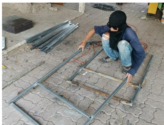
ซ่อมแซมโครงเดิมและทำโครงใหม่
