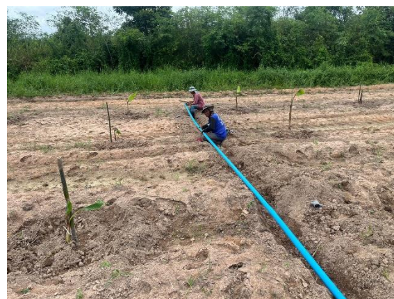
วางระบบน้ำ
